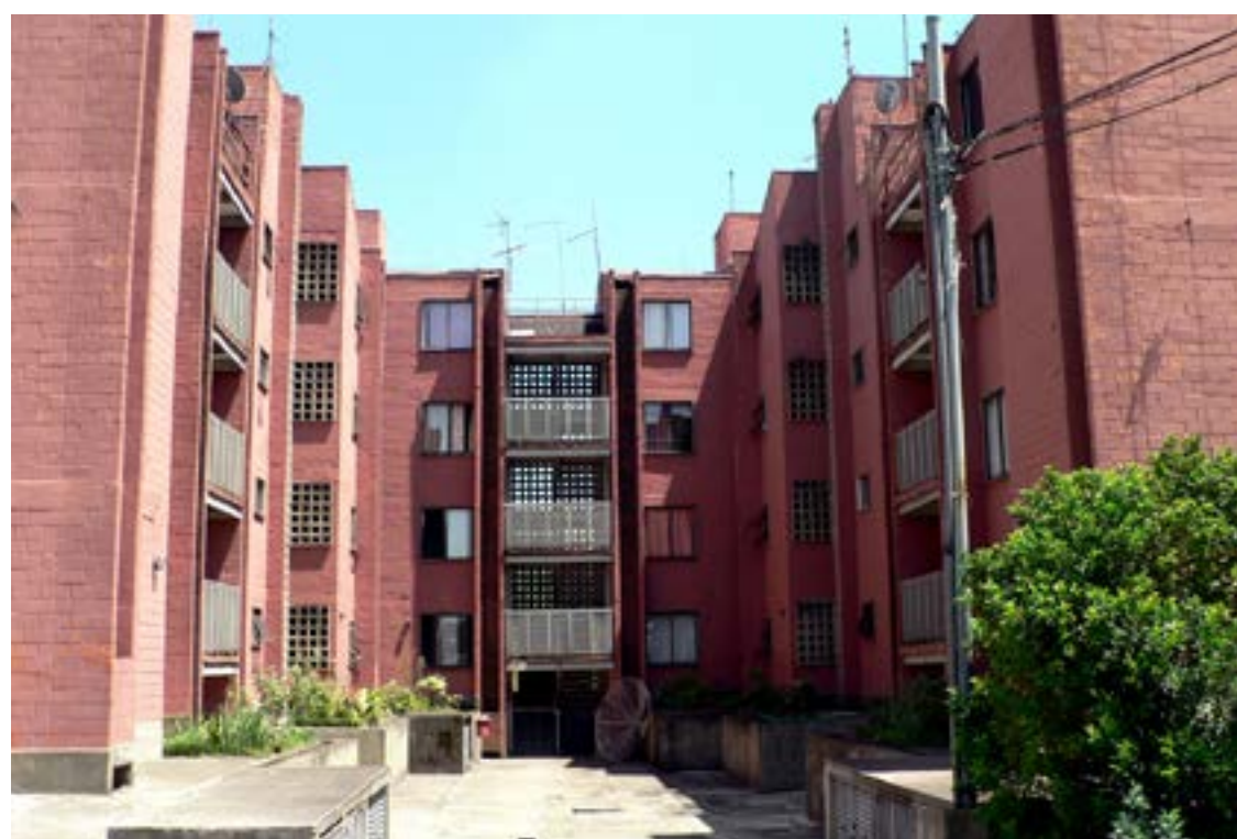
Postupem času kvůli menší dostupnosti pozemků začali architekti navrhovat jako vhodnější typ bytové domy. Projekt União da Jata se stavěl mezi lety 1993 a 1998. Jde o nosnou cihlovou konstrukci vyztuženou ocelovými schodišťovými věžemi, které nesou nádrže na vodu. (foto: Kužvartová 2015)
